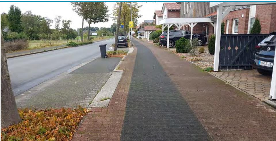
Abbildung 43: Gehwegüberfahrt mit getrenntem Geh- und Radweg im Seitenraum
