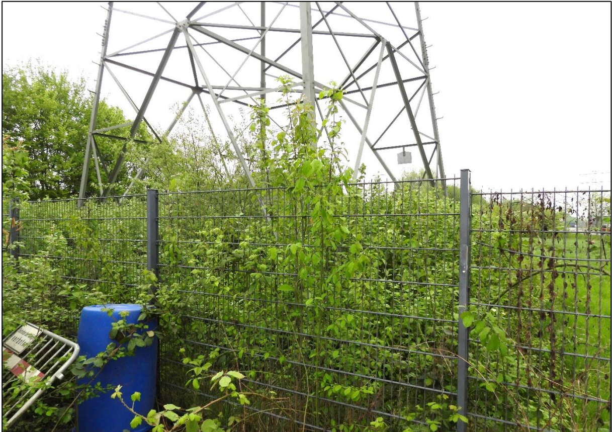
Abbildung 6: Hochspannungsmast mit ruderalem Aufwuchs (Brennnessel und Brombeere)
