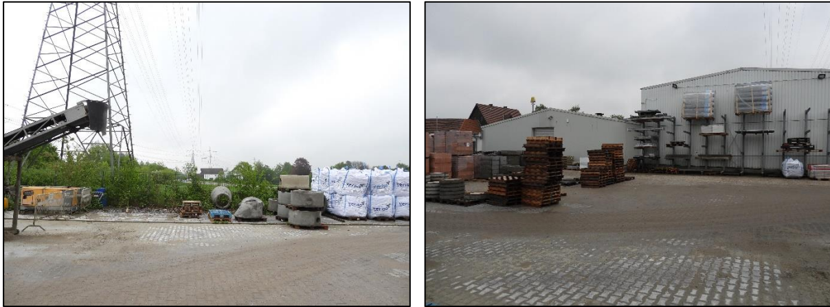
Abbildung 4: Bereich der östlichen Außenlagerflächen des Baustoffhandels
