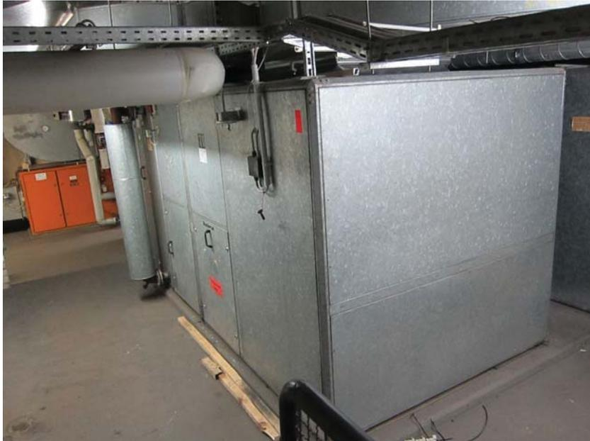
Abbildung 17-12: Anhang 11 - Lüftungsanlage Sporthalle (Lüftung Duschen im Hintergrund), Schulzentrum Nord-West
