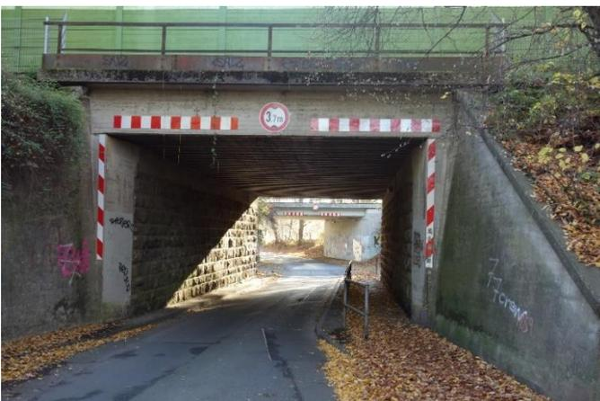
Abbildung 122: Mangelhafter Gehweg in der Unterführung
