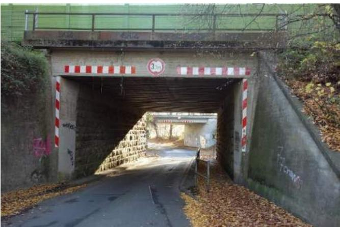
Abbildung 122: Mangelhafter Gehweg in der Unterführung
