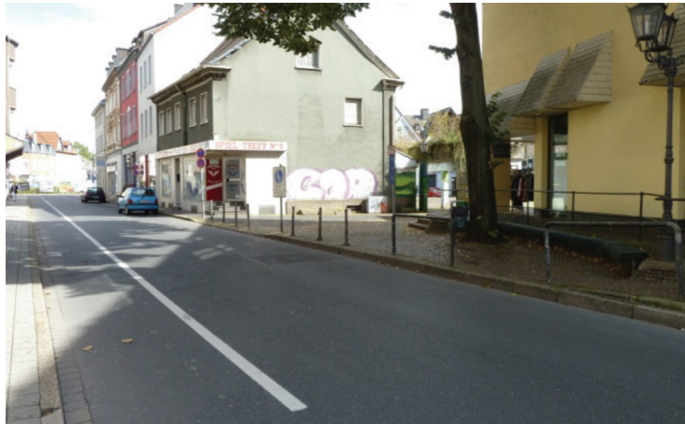
6.4.1_Erhöhter Gehweg auf der Südseite
