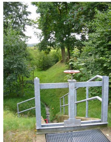
Der über einen Schieber eingestellte maximale Beckenabfluss ergibt sich aus dem Abflussvermögen der unter der Ortslage von Ergste verlaufenden Bachverrohrung.
