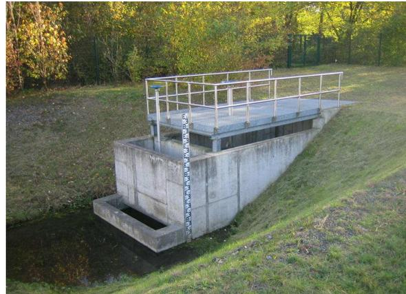
Mäandrierend durchfließt der Geisecker Bach das offene Erdbecken, an dessen Ende die Bachverrohrung beginnt. Über eine Schieberdrossel ist die Wassermenge eingestellt, die schadlos durch die Verrohrung passt.
