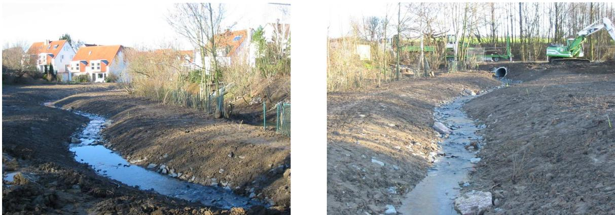
Der alte Durchlass unter der Bierstraße wurde entfernt und weiter nach Westen verlegt. Mit seinem neuen größeren Durchmesser von 1,30 m und einem 20 cm dicken Sohlsubstrat erfüllt der neue Durchlass die Empfehlung der „Blauen Richtlinie“ und ist durchgängig für Amphibien und Organismen.
