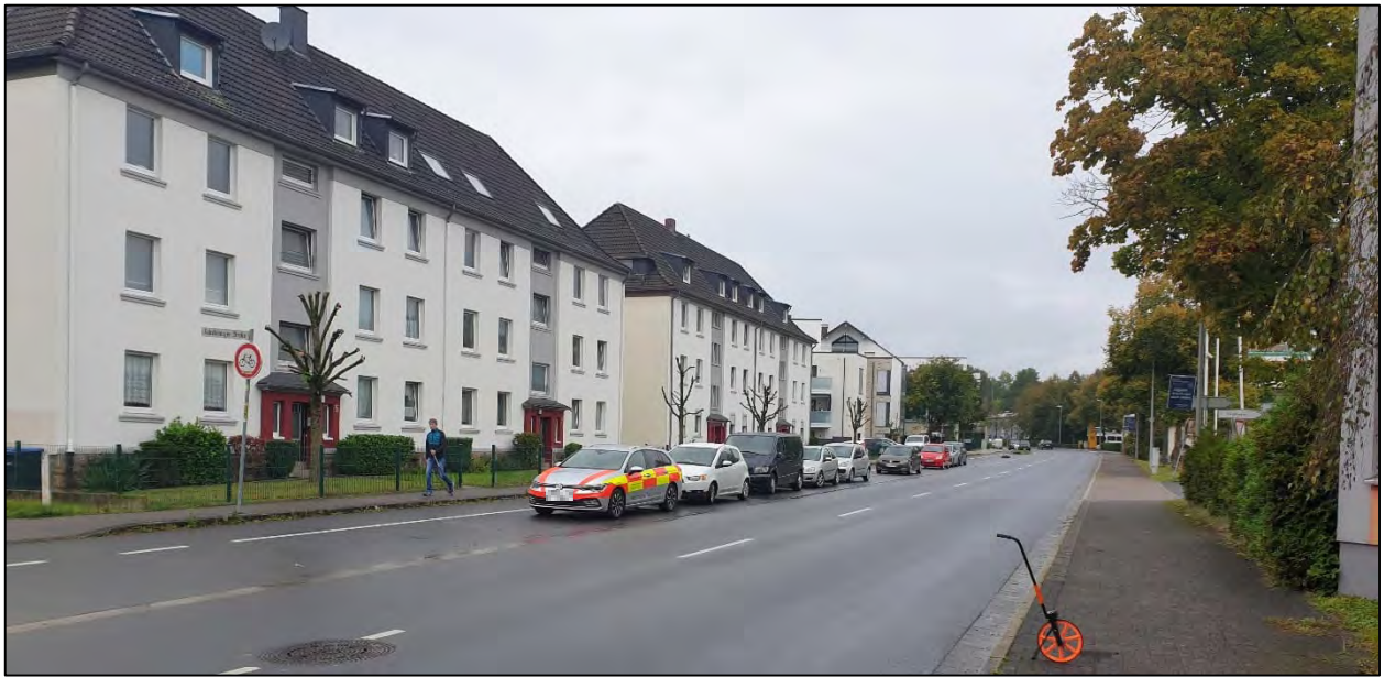
Abbildung 5: Derzeitige straßenräumliche Situation der Lohbachstraße, Blickrichtung Norden
