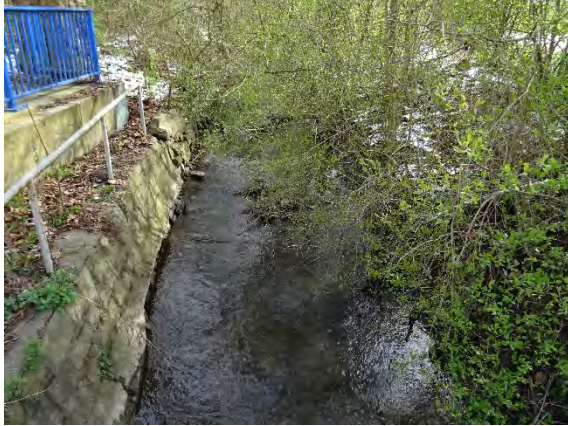
Mühlenstrang mit steilen Ufern am südlichen Rand des Plangebiets (südlich der Stellplätze)
