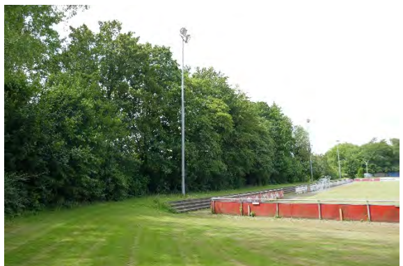
Sportplatz mit Gehölzstreifen am südlichen Rand des Areals aus vorwiegend heimischen Laubholzarten v. a. Feld-Ahorn
