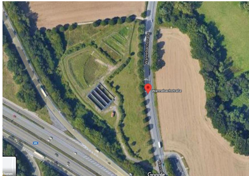
Bild 2: Blick auf das RRB an der Wannebachstraße.
