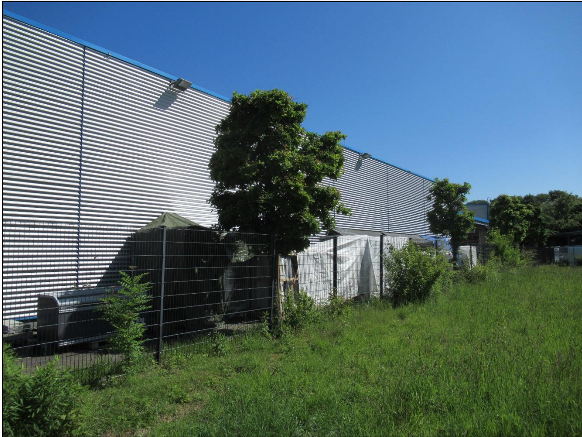
Abbildung 5: Baumreihe mit Stieleichen im Südosten und Gewerbehalle mit Blechverkleidung
