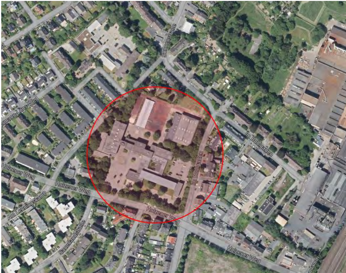
Foto 1: Bestandssituation (TimOnline, Luftbild)
