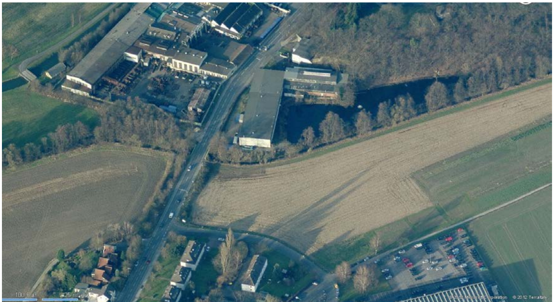
Abb. 13: Blick auf die südliche Erweiterungsfläche mit Elsebach und Firmengelände im Hintergrund
