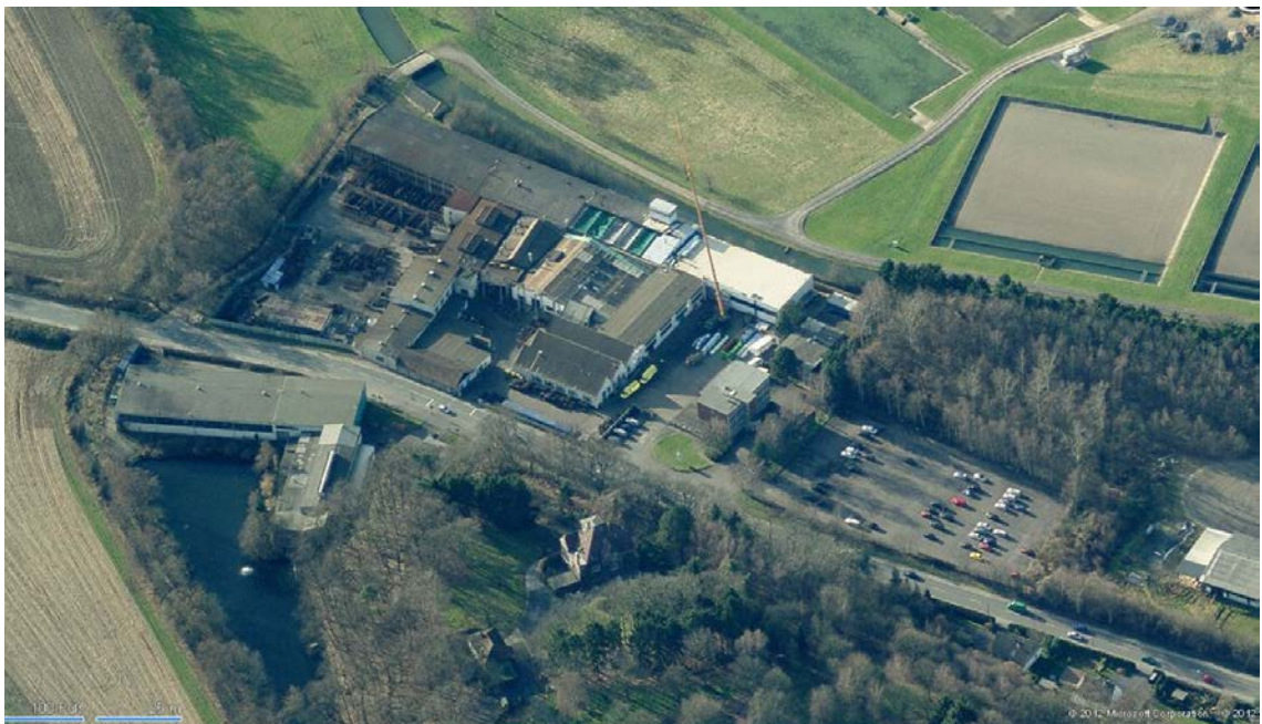
Abb. 12: Blick von Osten auf das Gelände der Firma J. D. Teile mit nördlicher Erweiterungsfläche
