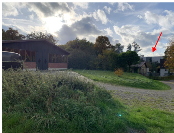
Geschotterte Zufahrt (nordwestlich des Plangebiets) zur Reithalle (links im Bild). Im Hintergrund der Industriestandort der Zapp AG
