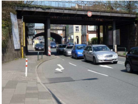
Hörder Str.: südliche Bahnunterführung (Erneuerung bei Umbau)
