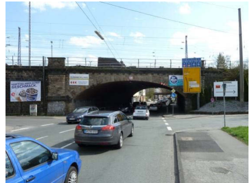
Hörder Str.: nördliche Bahnunterführung (bleibt erhalten)
