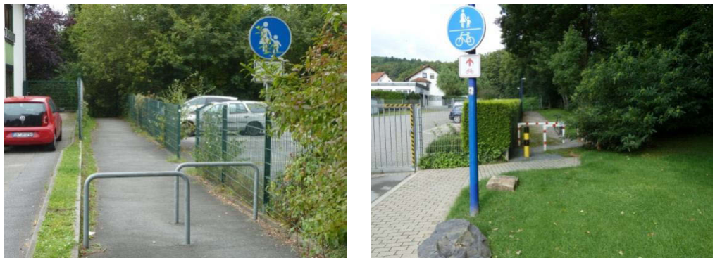
Abb. 34 Beispiele von nicht erforderlichen Pollern und Umlaufschranken
