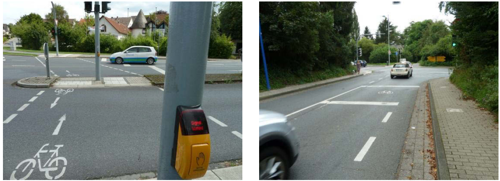
Abb. 33 Drucktaster zur Freigabebeanforderung am Knotenpunkt Letmather Straße B 236/Iserlohner Straße L648 in Villigst (links) und ARAS am Bürenbrucher Weg in Ergste (rechts)
