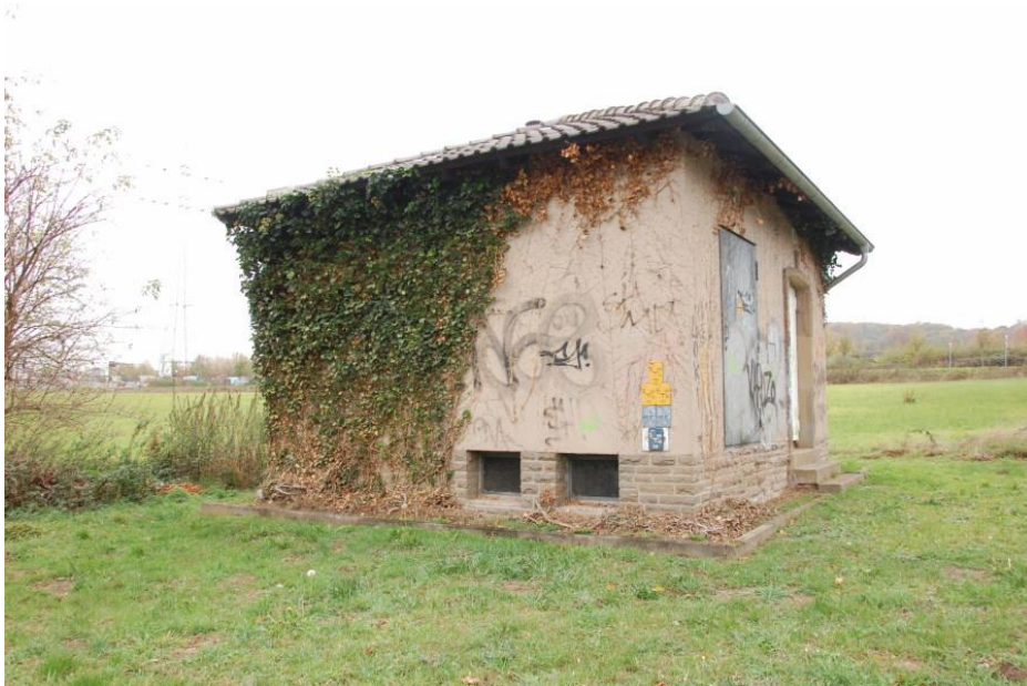
Das Trafo-Häuschen im Südosten der Fläche
