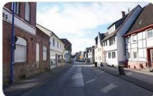
Gaßengangsbedeckung in der Reichshofstraße
