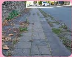
Nengelhofel Gehweg in der Schlossstraße
