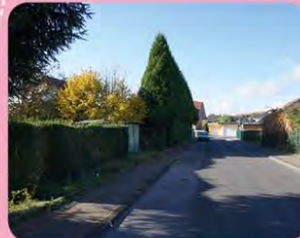
Mangelhafte Beleuchtung in der Jürgen-Velthaus-Straße
