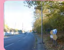
Mangelhafte Beleuchtung in der Hagener Straße
